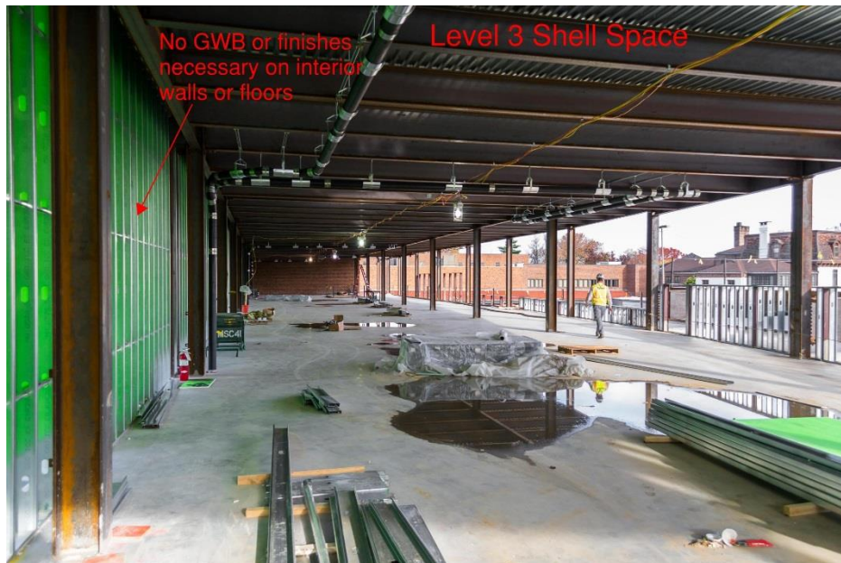
Level 3 Finishes – Actual View
